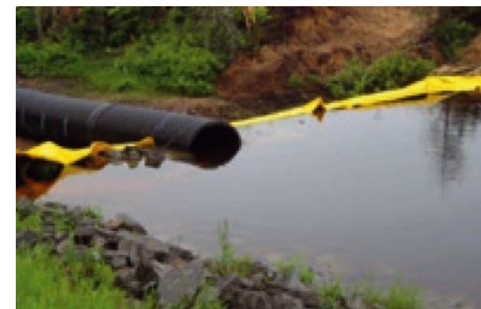
Photo 80 : Exemple de travaux de franchissement de cours d'eau en ensouillage Source : RTE
