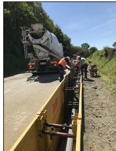
Photo 79 : : Illustration des travaux de raccordement réalisés par ENEDIS Source : RTE
