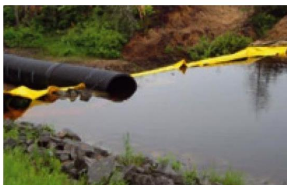
Exemple de travaux de franchissement de cours d'eau en ensouillage
